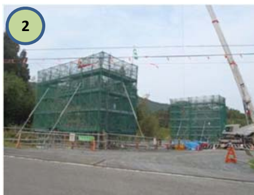
三滝川橋下部工施工状況
