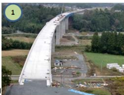
東日本 NEX 片倉高架橋完成状況
