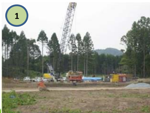
東日本 土工工事着手状況
