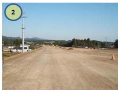
相馬IC付近土工事完成状況
