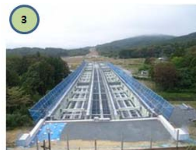
立田川橋架設状況
